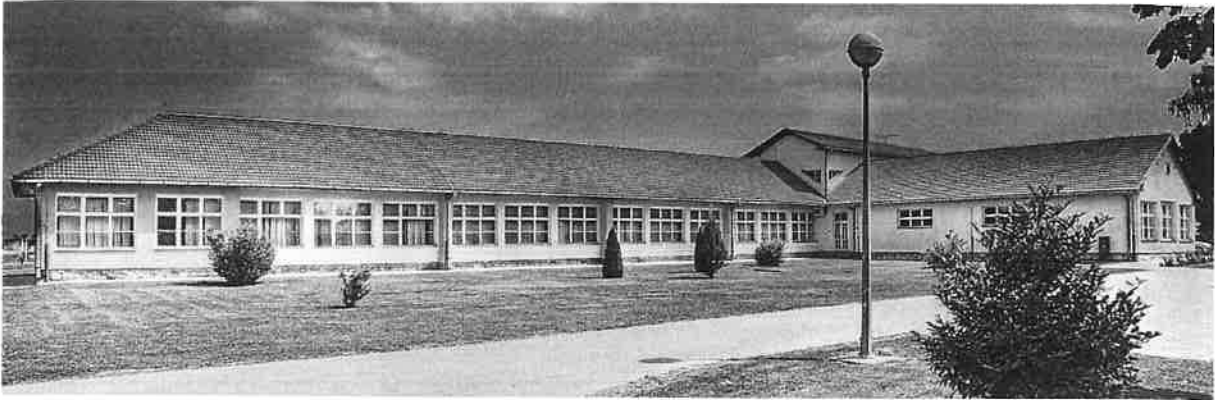
Privitak 1: Fotografija matične škole i instaliranog klimatizacijskog uređaja
