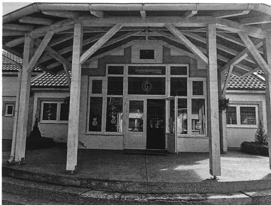
Privitak 4: Fotografija PŠ Turanovac i instaliranog klimatizacijskog uređaja
